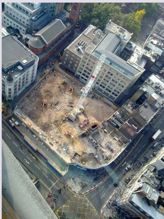
Budowa stacji kolejowej Tottenham Court Road Crossrail w Londynie.
